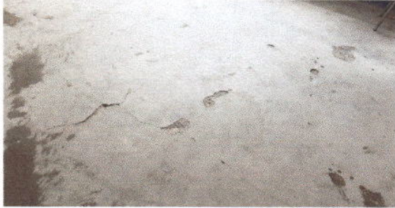
Foto1: Sustrucción de piso cerámico
