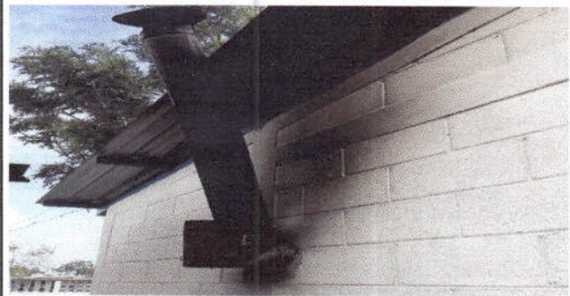
Foto 4: Sustrucción de chimenea de concreto
