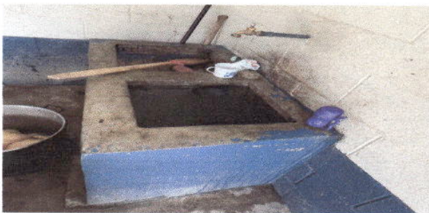
Foto 5: Sustrucción de pila de plástica de dos lavaderos
