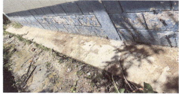
Foto 2: Reparación de cuneta de concreto
