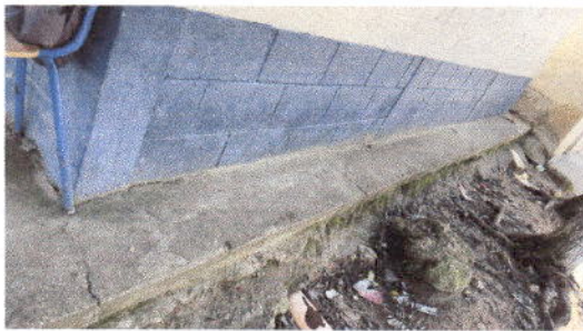
Foto 3: Reparación de banquetas de concreto
